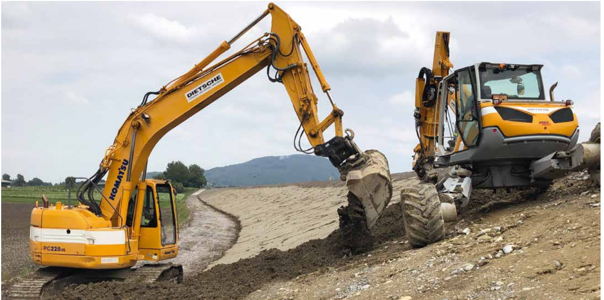
Mit der Verstärkung der Rheindämme und damit der Verbesserung des Hochwasserschutzes erhalten die Dämme auch ein «Facelifting».
