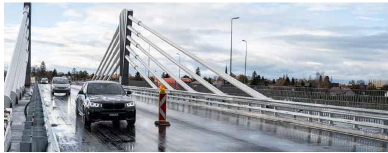
Nach 28 Monaten Bauzeit konnte die neue Brücke am 18. November 2022 erstmals vom Individual- und Busverkehr befahren werden.
