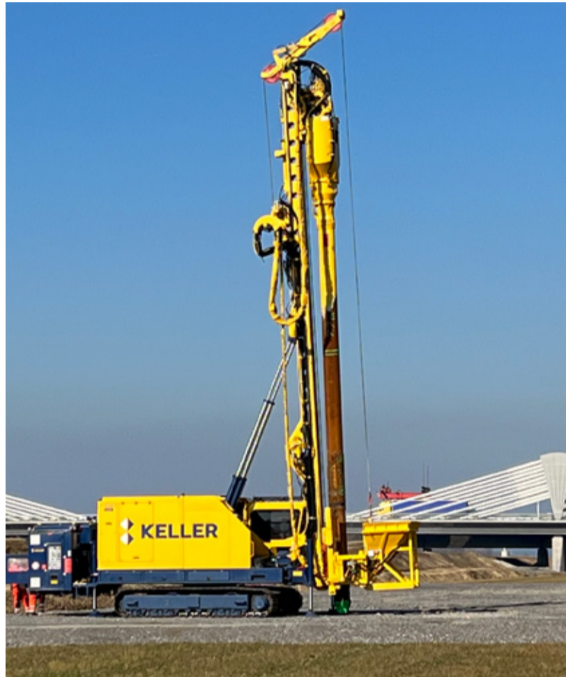
Versuche mit 70 Tonnen schweren Maschinen im Rheinvorland. Im Hintergrund: die neue Brücke Hard-Fussach.
