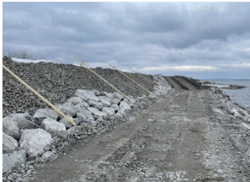
... dann der erhöhte Damm geplästert.
