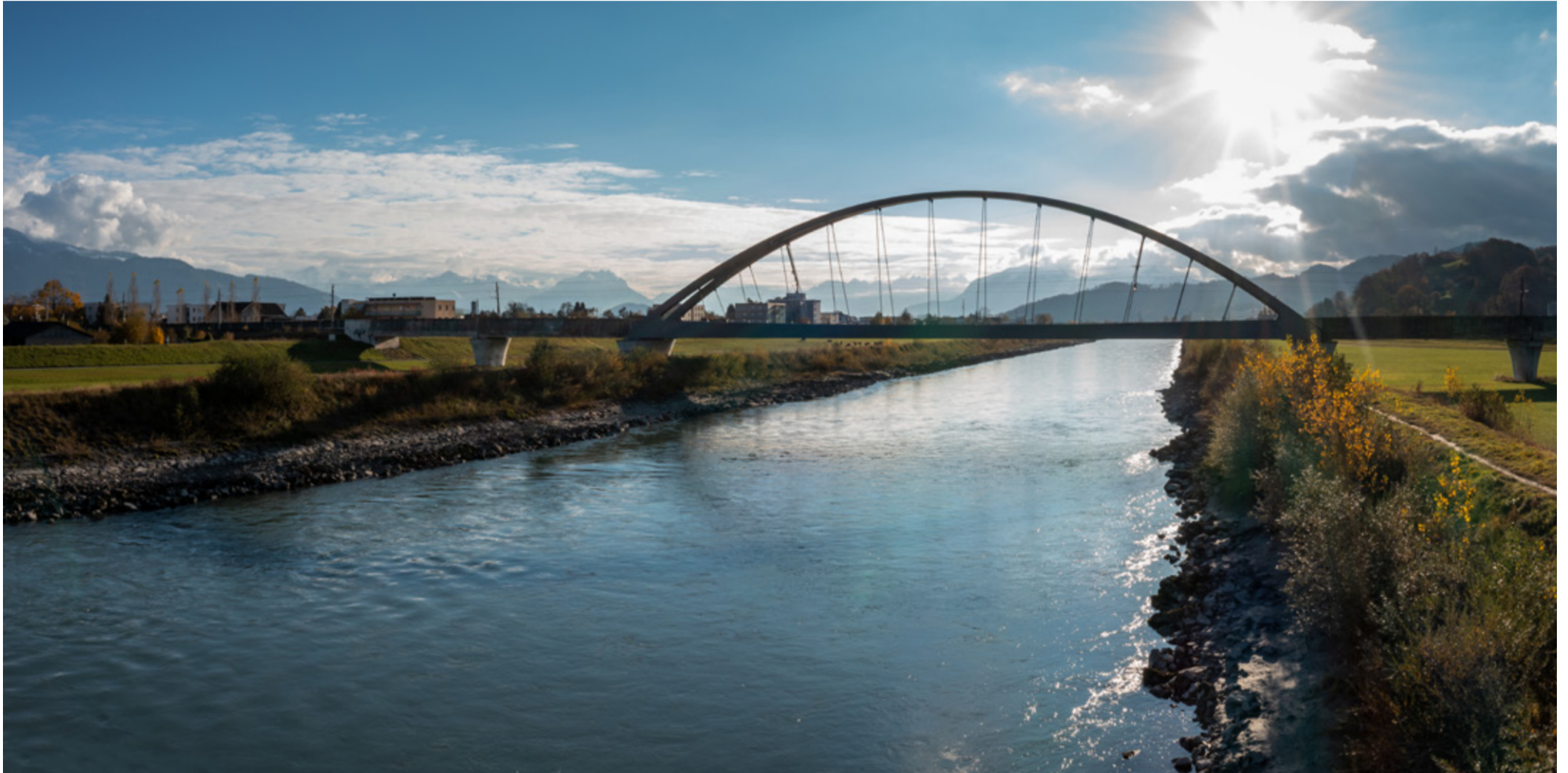
Die Wassermenge, die im Alpenrhein fliesst, hat Auswirkungen auf Höhe und Qualität des Grundwassers. (Quelle: Internationale Rheinregulierung (IRR))
